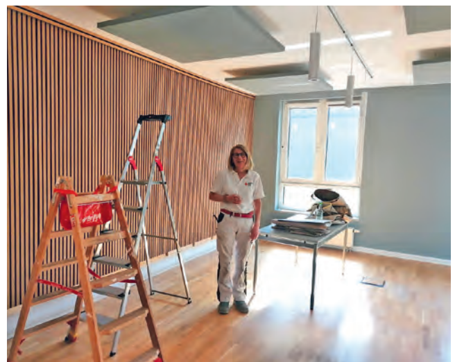
Der frühere einfache Eingangsbereich im ersten Stock im Bildungszentrum wurde komplett verändert.
