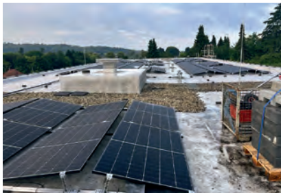
Die Module aufzubauen war ein Faktor, entsprechende Verbindungsleitungen zu legen ein weiterer. Auch in Sachen Blitzschutz wurde ein ausgetüfteltes System auf die Dächer gebracht. Die Anlage läuft reibungslos und sorgt für beruhigende Sicherheit.
