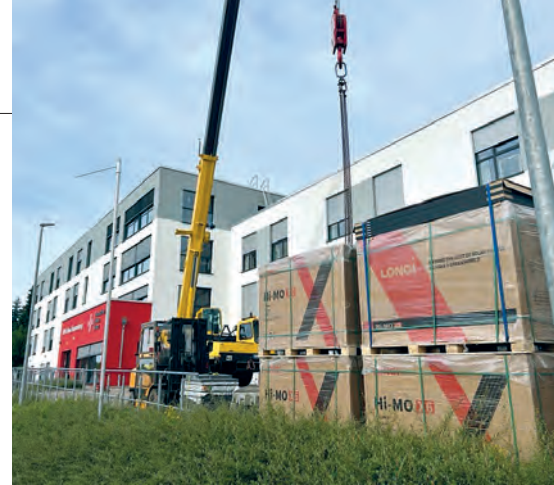
Viele Arbeitsschritte bis zur Fertigstellung waren notwendig. Die Anlieferung der Module erforderte auch den großen Kraneinsatz unmittelbar an dem auf einem Hang gelegenen Seniorenheim in Borgholzhausen.
