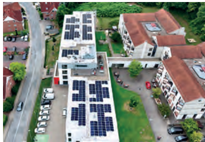
Das Luftbild zeigt die ganze Dimension der Solaranlage, die künftig gemeinsam mit den anderen Komponenten dafür sorgt, dass eine Selbstversorgung tagelang möglich ist, ebenso wie warme Mahlzeiten für die Auslieferung.
